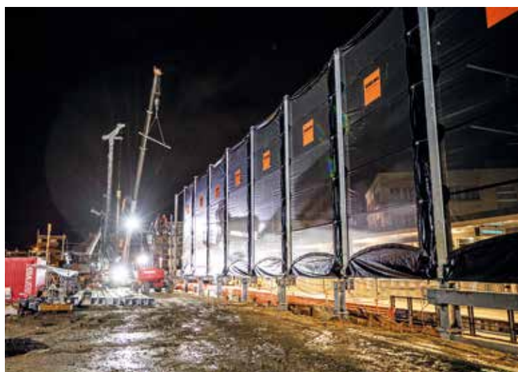
Bei bahnahem Bauen kommen oft Schutzgerüste zum Einsatz.
