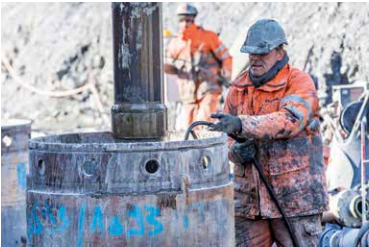
Die Grossbaustelle verlangte grosse Flexibilität der Mitarbeitenden.
