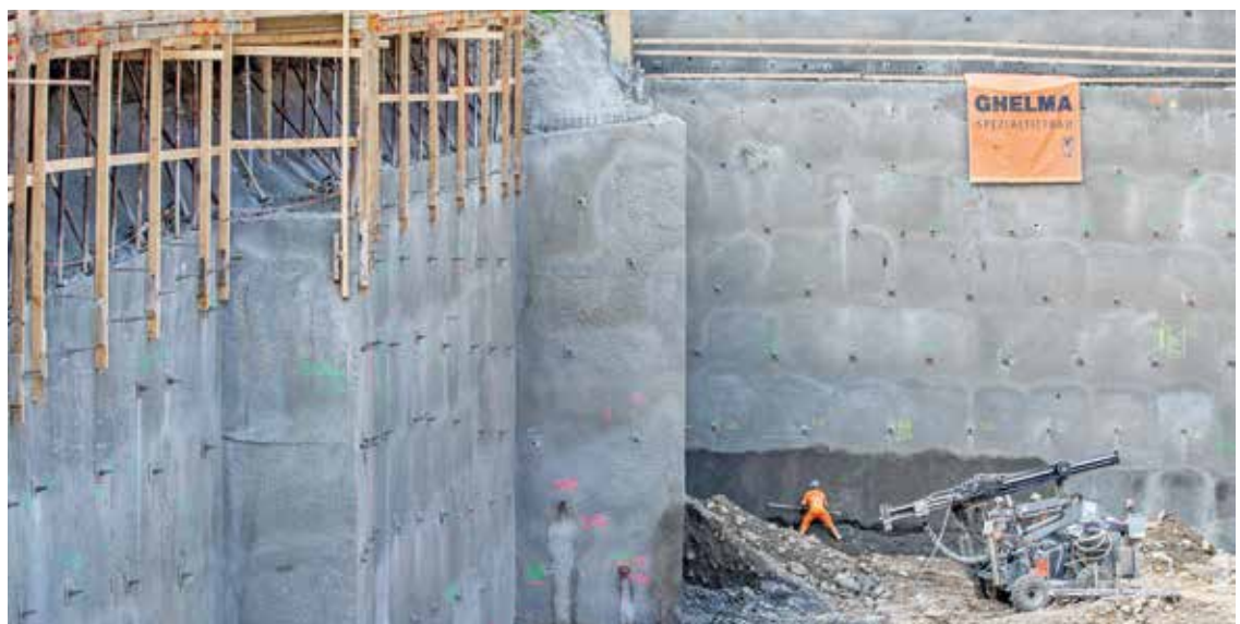
Beim System VNM handelt es sich um eine vorgespannte Nagelwand mit Mikropfählen, die hauptsächlich bei tiefen Baugruben zum Einsatz kommt.
