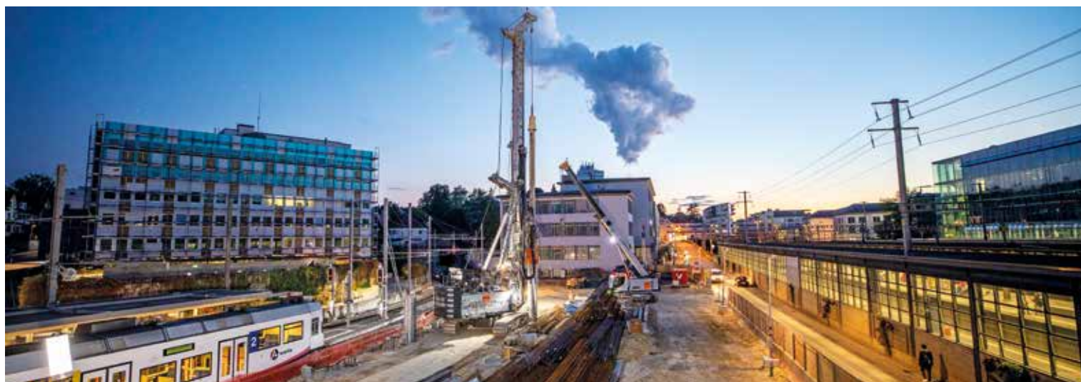
An zentraler Lage entsteht in Aarau mit dem Bahnhof Aarau Süd ein moderner Gebäudekomplex.
