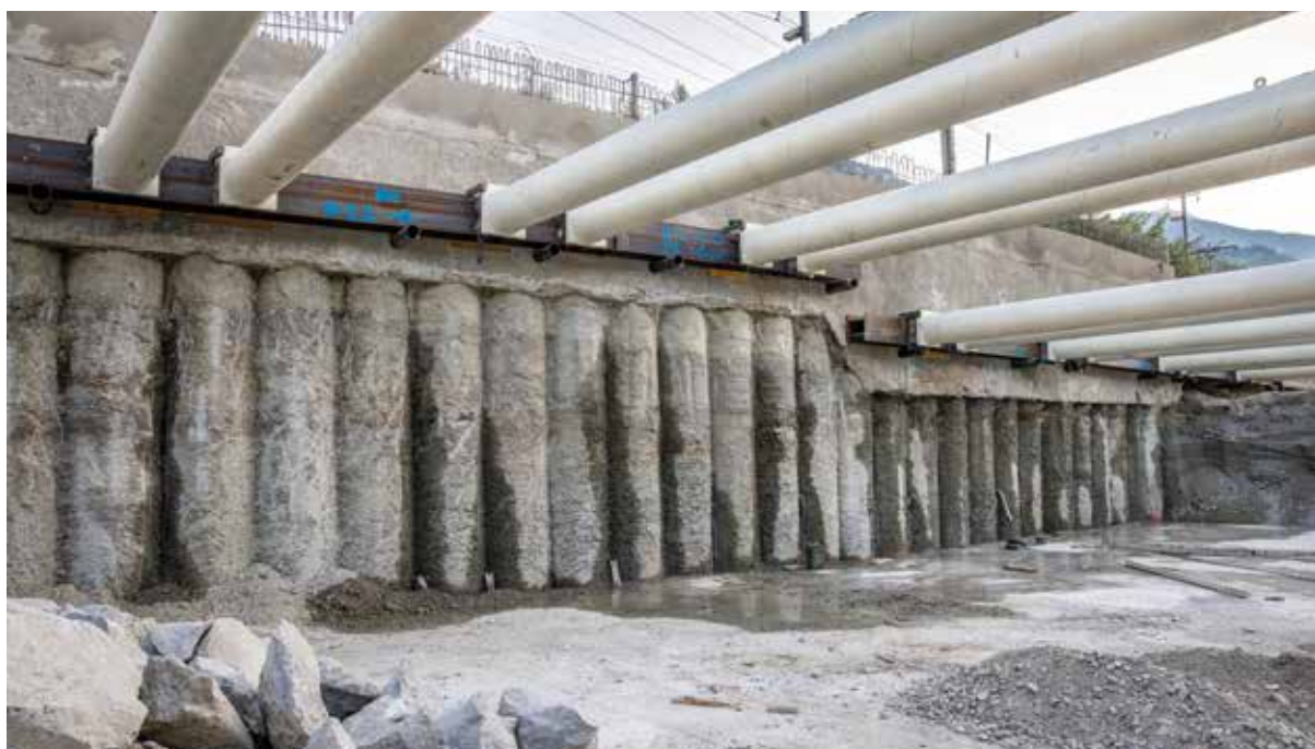
Ende Oktober 2020 wurde der letzte von 2980 Ortbetonpfählen gebohrt.
