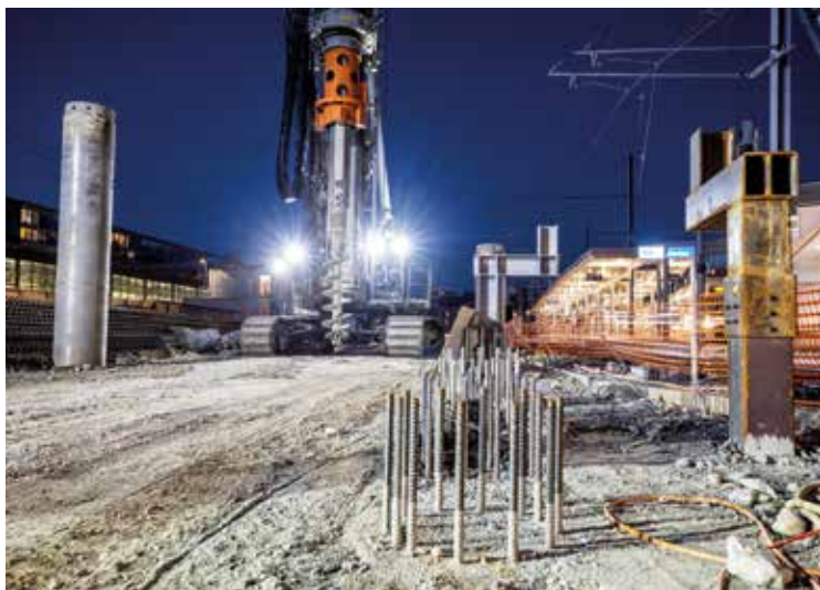
Die Lärmemissionen mussten auf ein Minimum reduziert werden.
