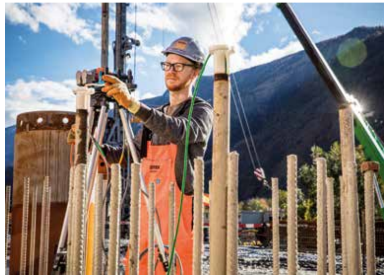
Bei Projektbeginn führte die Geotek Inclinometer-Messungen durch.
