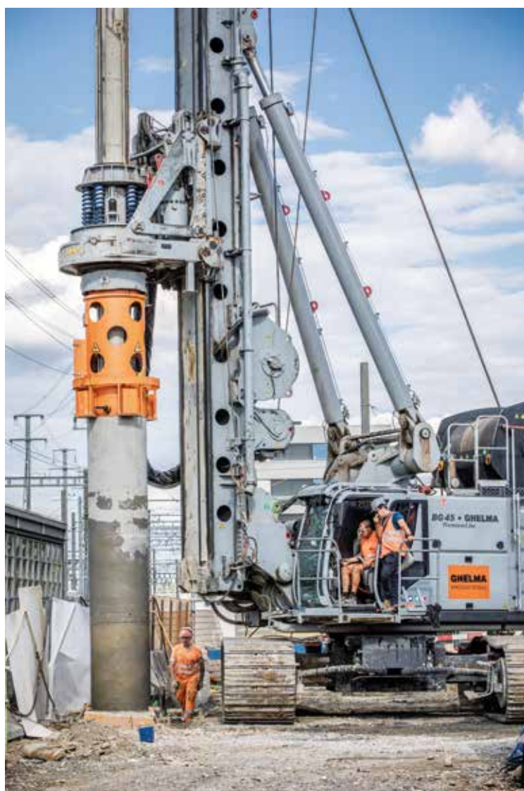
Enge Platzverhältnisse: Die Baustelle liegt zwischen Geleisen mitten am Bahnhof Aarau.
