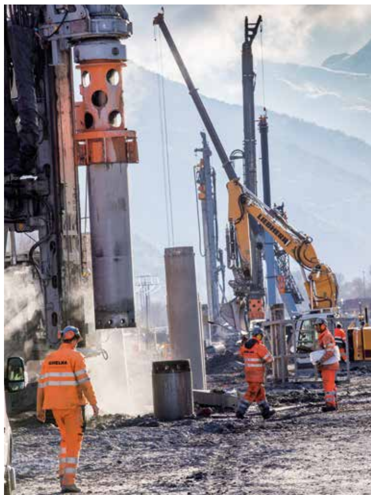
Die Drehbohrgeräte ragen bis zu 30 Meter in die Luft.
